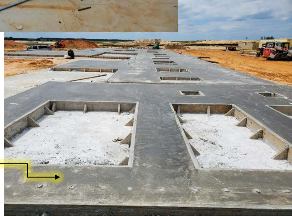
September: tilt panels forming, reinforcing and pour
